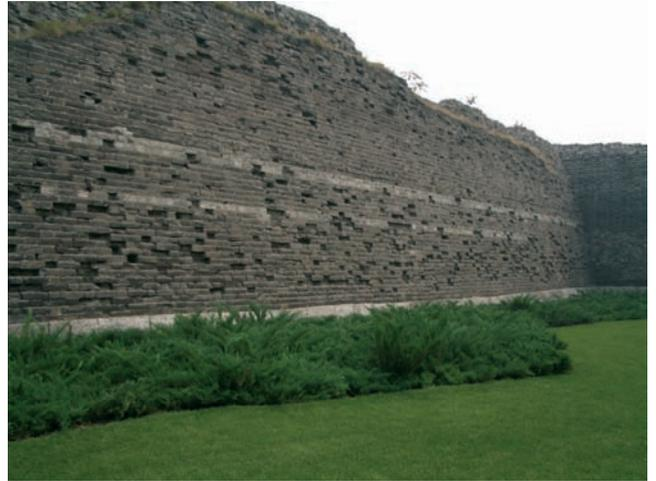
La muralla de Pekín. La disposición aleatoria de los huecos que presenta se ha producido por el deterioro de parte de los ladrillos utilizados en su construcción.
