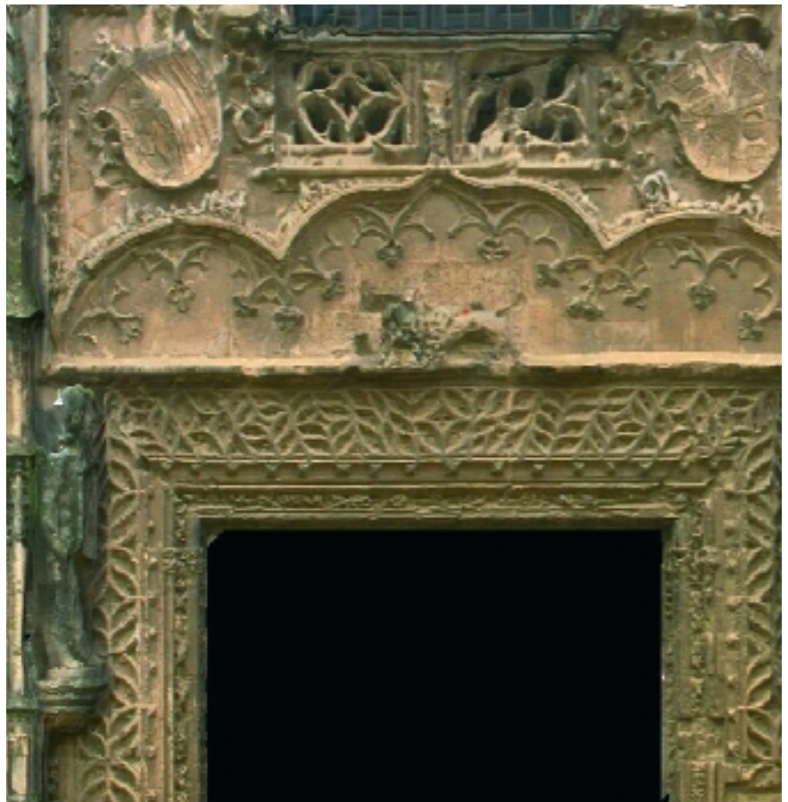
Figura 6. Detalle de ortofoto. Elaboración propia a partir de nube de puntos escaneados por Riegl Measurements Systems GmbH
