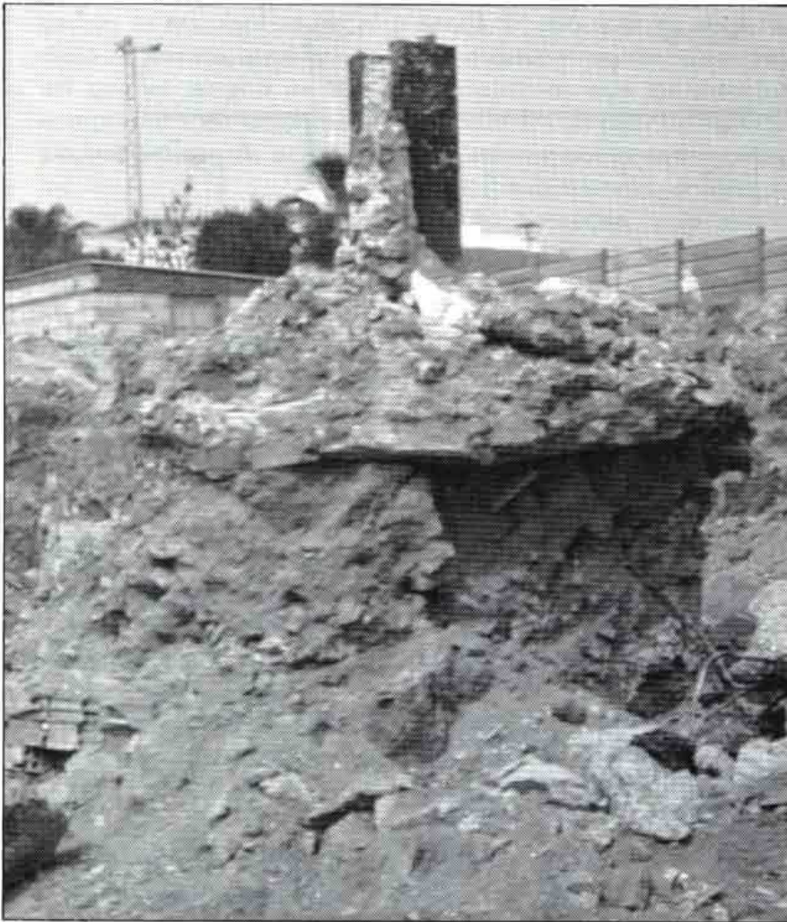
ZAPATA SOBRE RELLENO después de realizar la excavación en profundidad del terreno circundante.
