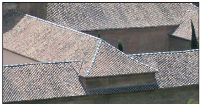
5.- Hemos de tener en cuenta si la cubierta del nivel inferior afecta, o no, a la de nivel superior. O dicho de otro modo, que cuando resolvamos la cubierta de nivel superior hemos de tener en cuenta si le afecta la del nivel inferior.
