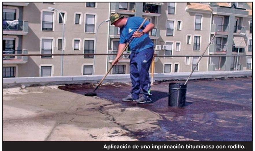
Aplicación de una imprimación bituminosa con rodillo.
