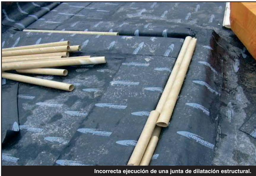
Incorrecta ejecución de una junta de dilatación estructural.
