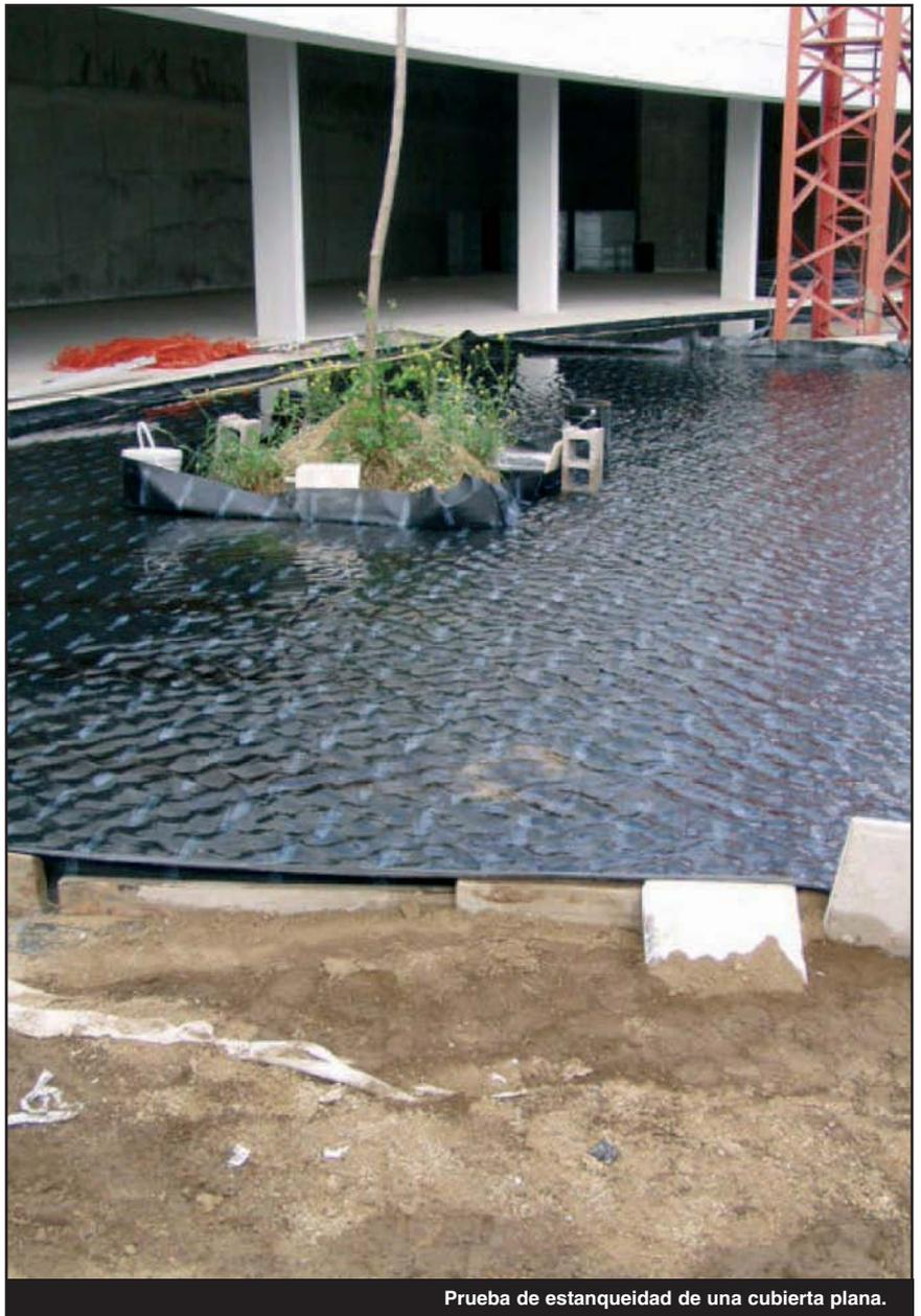
Prueba de estanqueidad de una cubierta plana.
