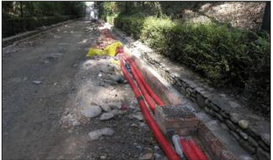
Colocación de tubos para instalaciones eléctricas. Se aprecia la ejecución de nuevas arquetas a la cota final de la calzada, así como de un cajón continuo para la instalación en limpio de los tubos. 17/09/07
