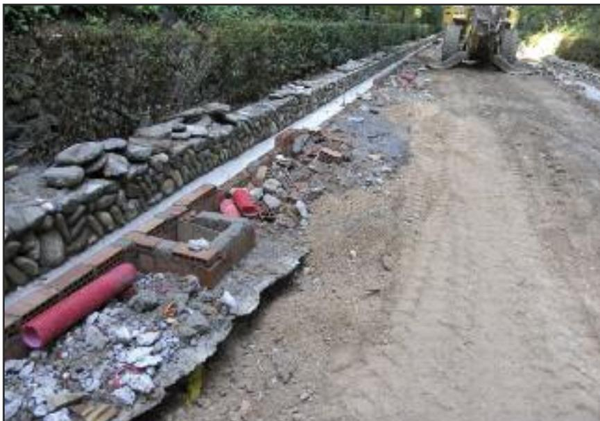
Ejecución de la base de las acequias. Se aprecia el acopio de losas de piedra de reutilización para el remate lateral de la acequia. 24/09/07
