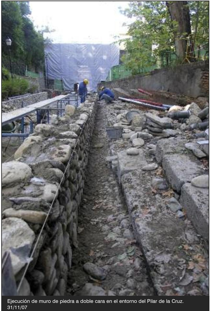
Ejecución de muro de piedra a doble cara en el entorno del Pilar de la Cruz.
