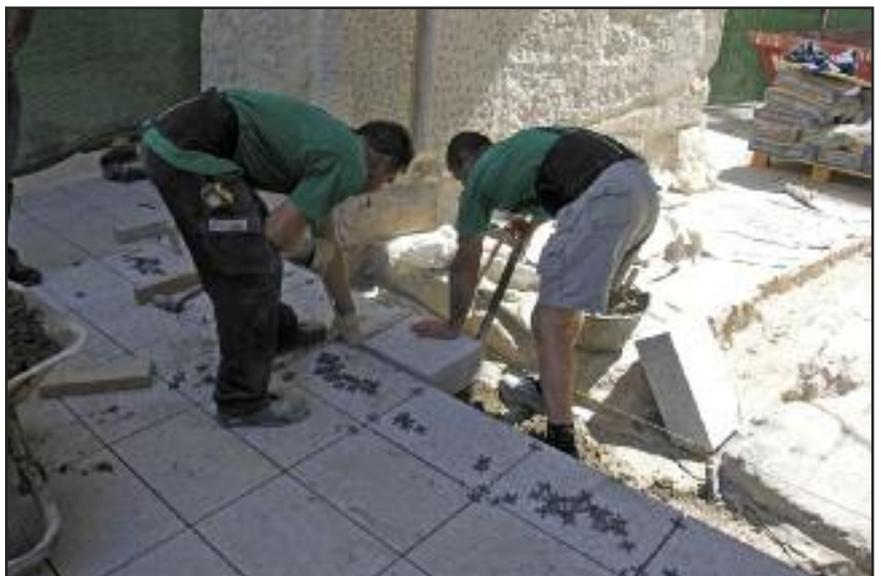
Colocación del pavimento de granito con junta abierta en las proximidades del arco central de la Puerta. 23/07/08
