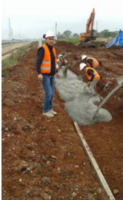
Ejecución de soleras de hormigón (Marruecos)
