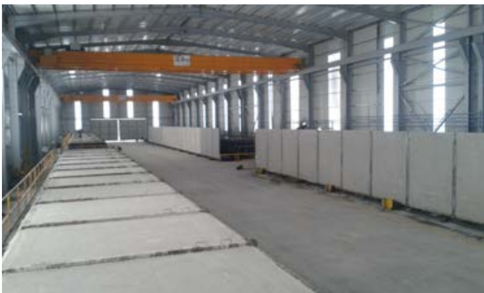
Muros realizados para retirar de las mesas giratorias (Marruecos)
