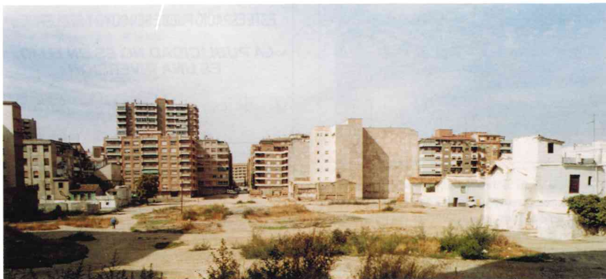
Vista actual del Barrio de S. Lázaro
